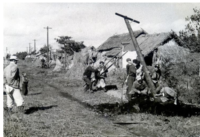
電柱を立てる
