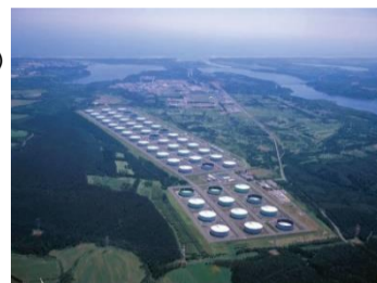
むつ小川原国家石油備蓄基地
