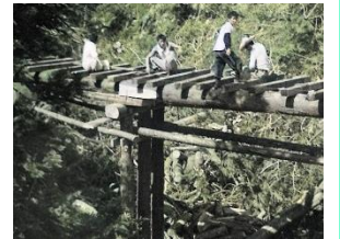
橋を架ける工事の様子
