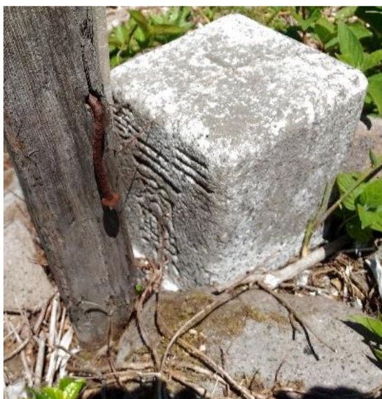
陸地測量部三角点は、「三等三角点」と刻印されている
